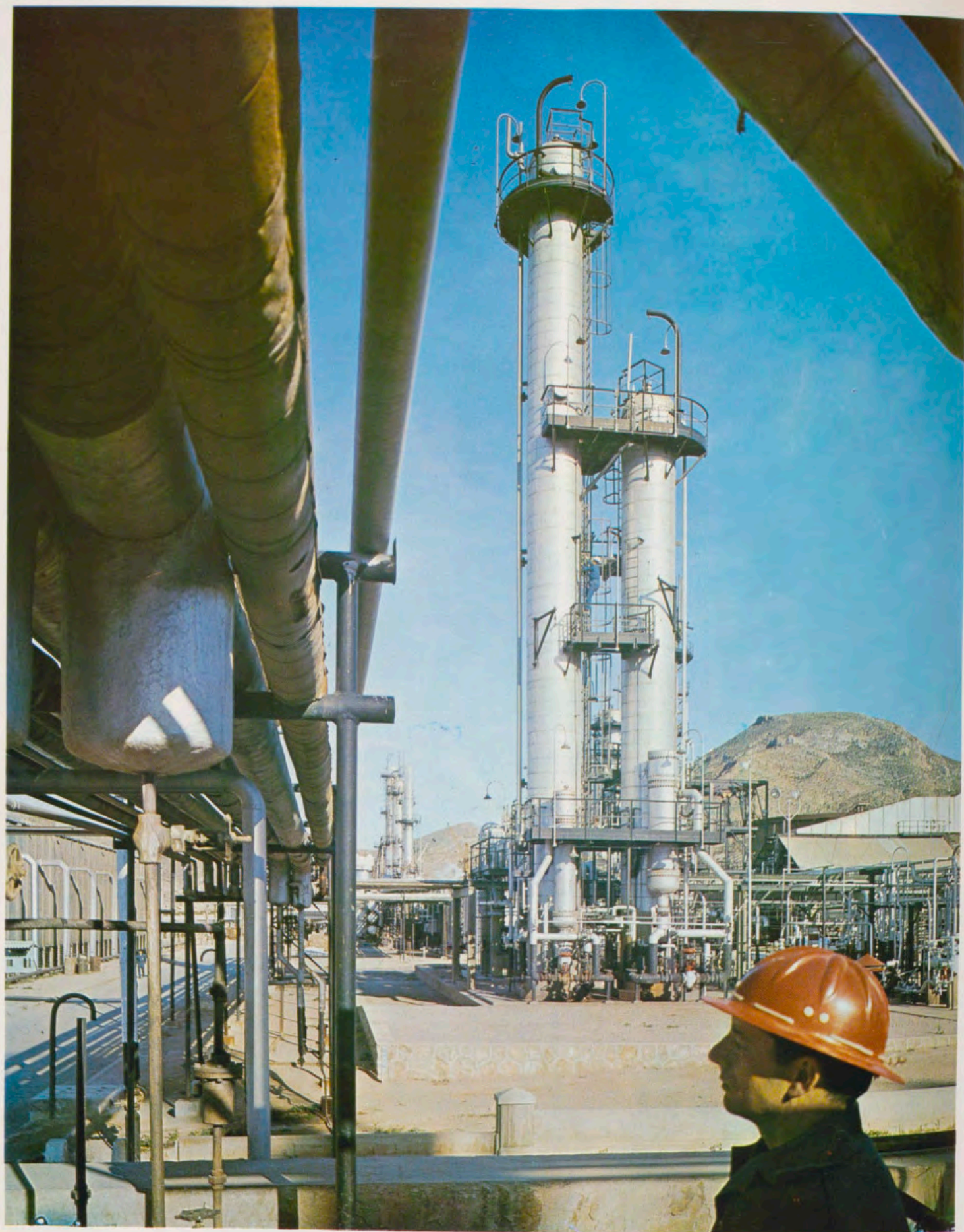
REFINERIA DE PETROLEOS DE ESCOMBRENAS, S. A. (CARTAGENA)
