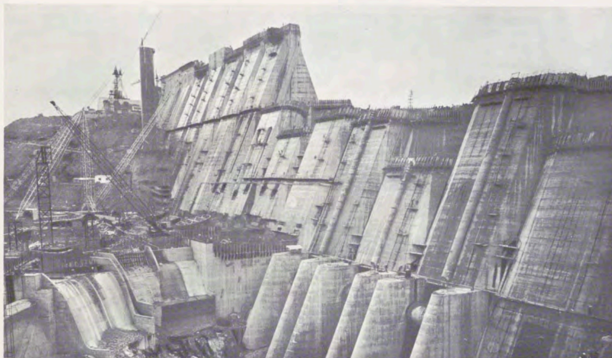
Obras en ALCANTARA ▲
