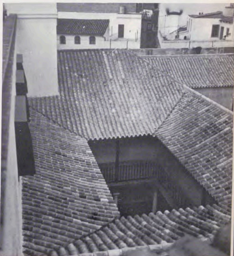
Las cubiertas de esa zona debidamente ordenadas tras su reconstrucción.
