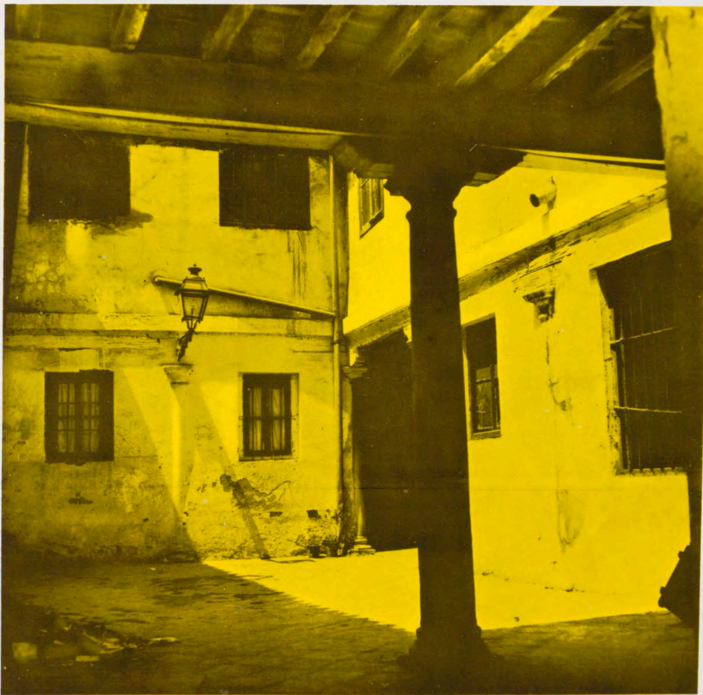
Patio del Almirante antes de las obras: cegadas sus galerías, ocultas en parte las columnas y con triste aspecto de abandono.
