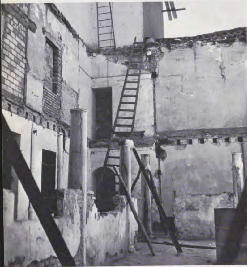
El patio del Almirante durante la demolición y desmontado de añadidos. Obsérvense en las columnas (línea sinuosa oscura, como si fuese una grieta) los caminos de las termites.
