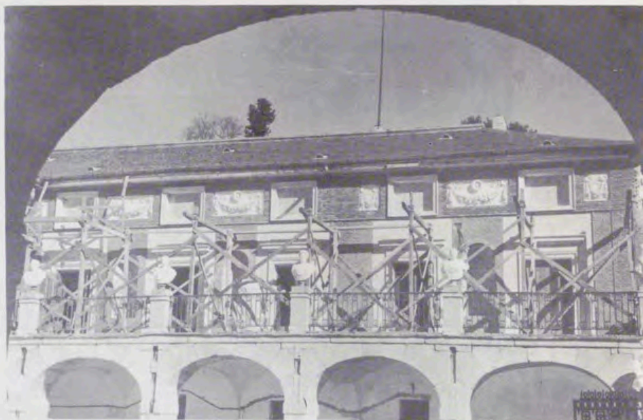
La misma fachada en estado avanzado de obras.
