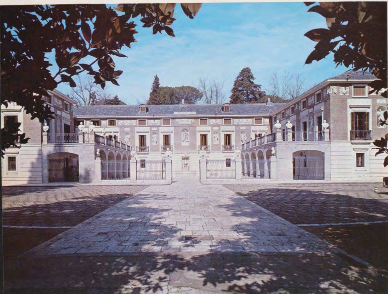
Fachada principal de la Casa del Labrador, en Aranjuez.
