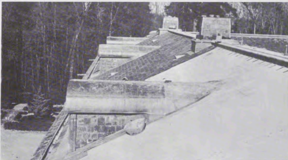
Colocación de pizarra y plomo en los nuevos faldones sobre cama de yeso.
