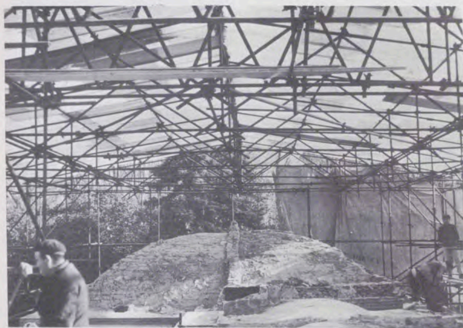
Aspecto de la bóveda tabicada del salón de billar. Su trasdós fue enfoscado. Las formas metálicas se construyeron con el peralte debido para salvar su volumen.
