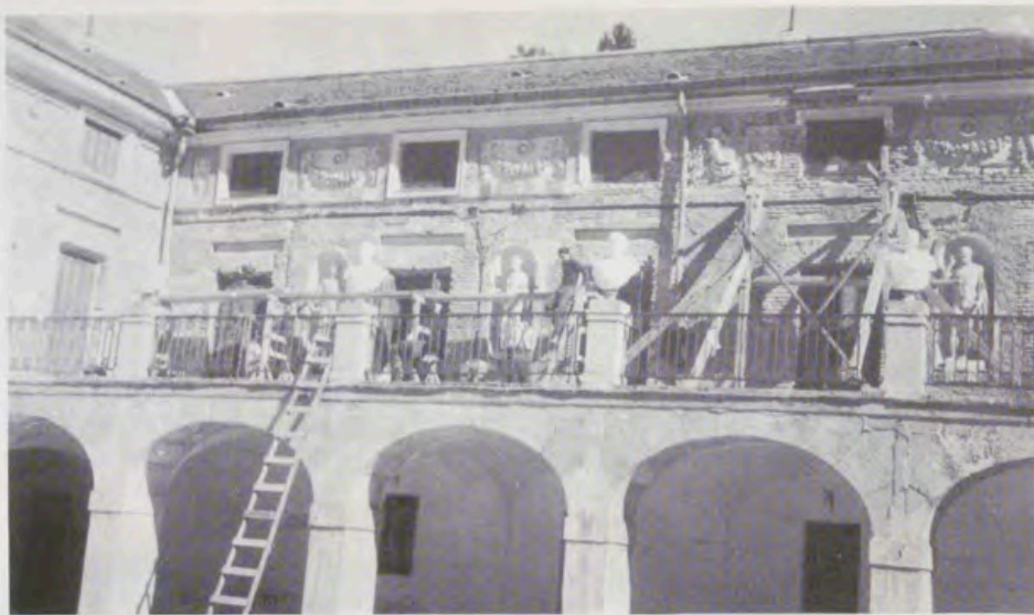
Fachada lateral interior durante la restauración.
