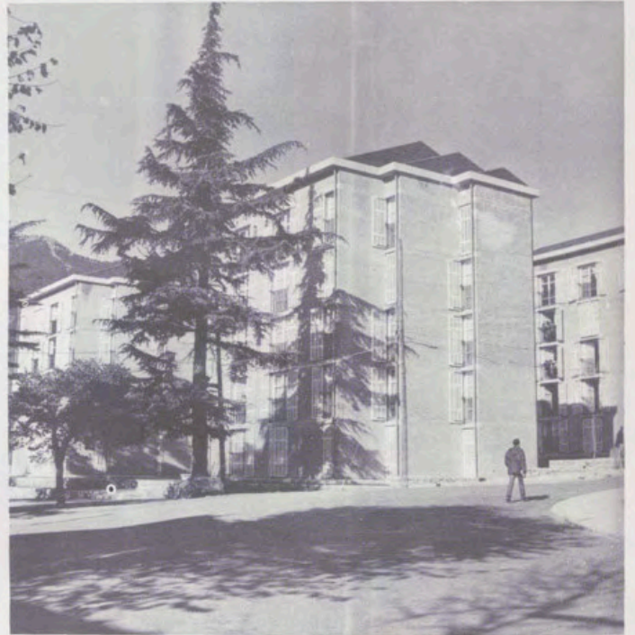
Viviendas en El Escorial, para obreros y empleados del Patrimonio.
