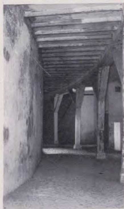
Galería baja que circunda los tendidos y que sirve de acceso al público.
