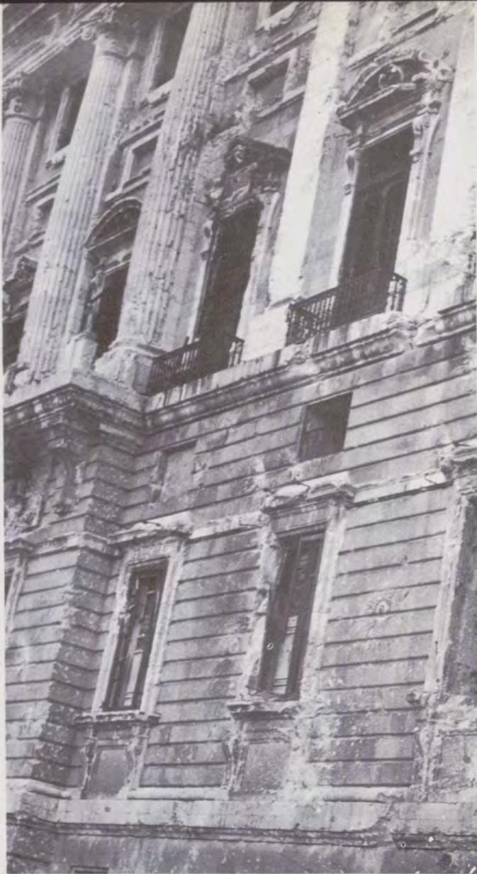
Aspecto de la fachada antes de su reconstrucción.
