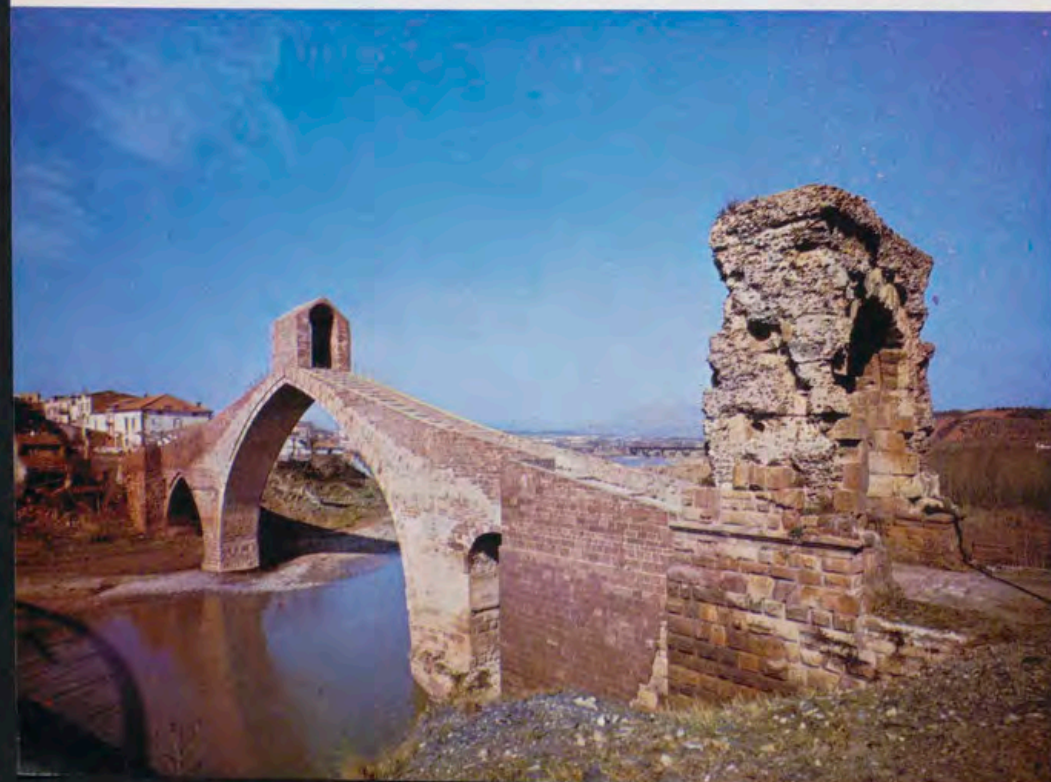
Martorell, Puente medieval sobre el Río Llobregat.
