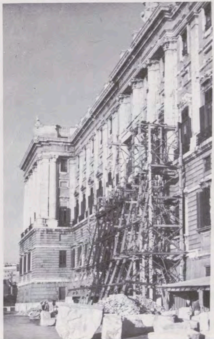
Perspectiva del edificio y de la obra. En primer término, los bloques de piedra, que se labran en el mismo lugar.
