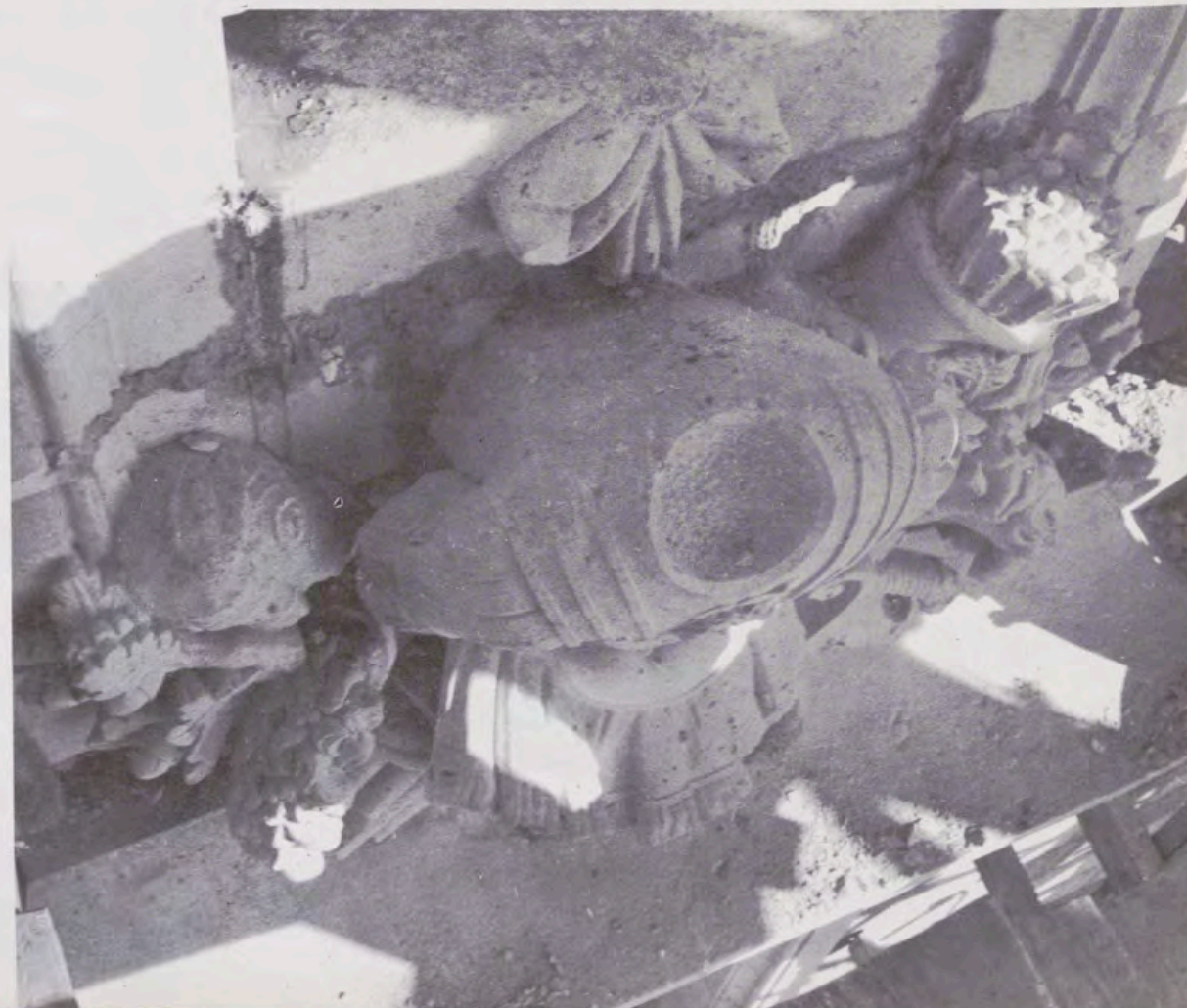
Detalle de uno de los motivos escultóricos, de fuerte volumen, que ayudan a sostener las ménsulas del balcón en voladizo.
