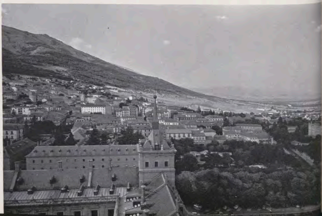
Parte del Monasterio en primer término. Después, el pueblo. Al fondo, la sierra. Más lejos, aún, la Santa Cruz del Valle de los Caídos.
