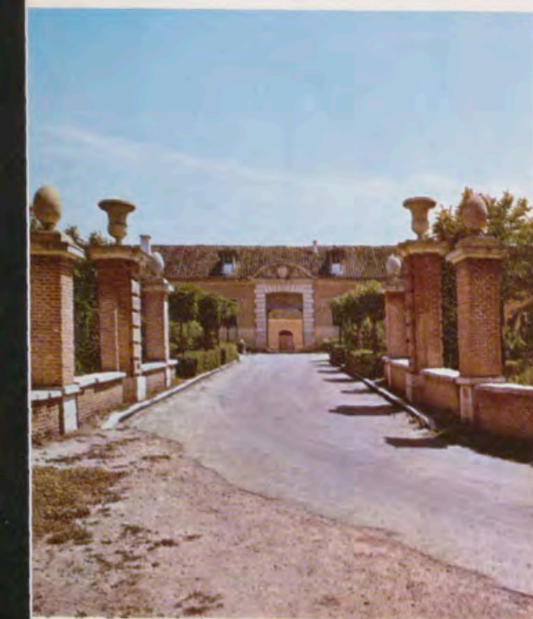
Entrada principal a la finca.
