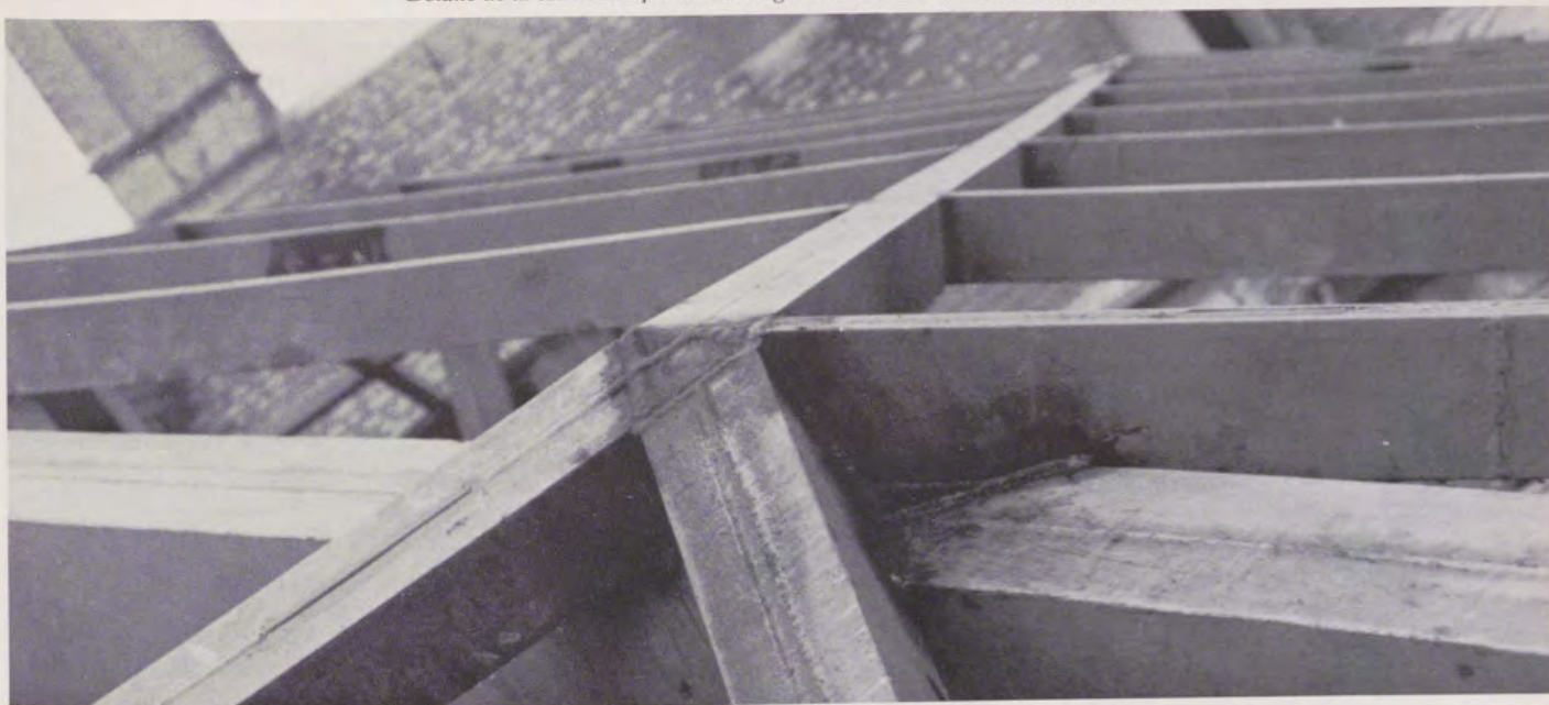
Detalle de la estructura portante octogonal sobre uno de los arcos diagonales.
